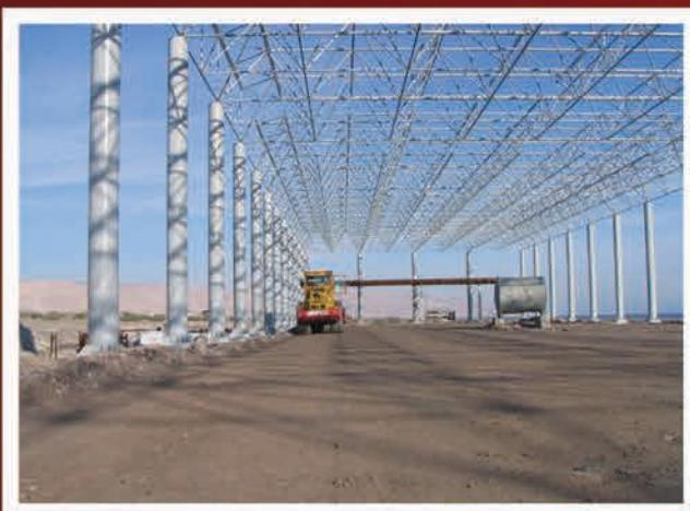
■ سرعت بالا در مرحله تولید، حمل و نصب سازه از دیگر خصوصیات بارز آن می باشد که در کاهش زمان تکمیل پروژه و به دنبال آن کاهش هزینه های اجرایی پروژه نقش مؤثری دارد. همزمانی پروسه تولید و اجراییکی از مشخصه های مهم این سیستم می باشد که بر روی سرعت کار اثر فوق العاده ای دارد.
